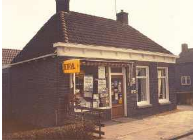
Foto uit 1972 van het winkelpand aan Badweg 19
